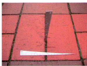
Рисунок 32. Измерение ширины шва при восстановлении покрытия
