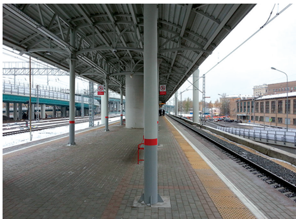
Рисунок 16. Покрытие железнодорожного перрона
