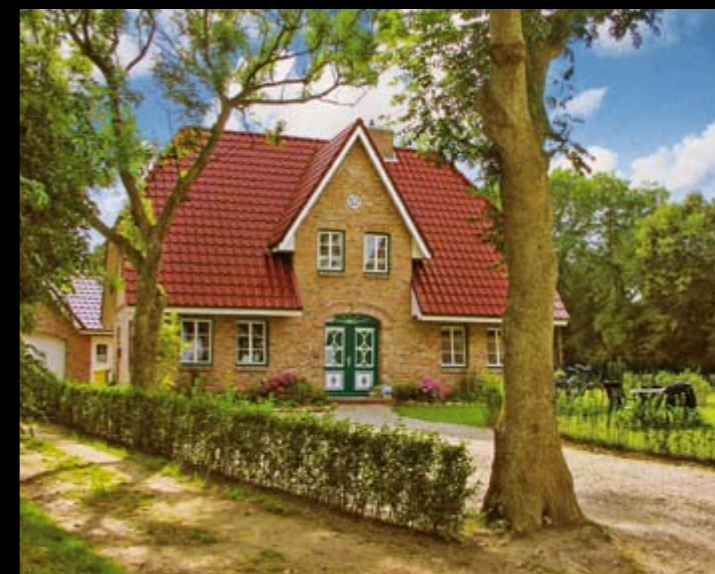
Красивый вид крыши дома на фоне зелени: крупноформатная черепица FLANDERNplus саунте. Сплошной блеск.
