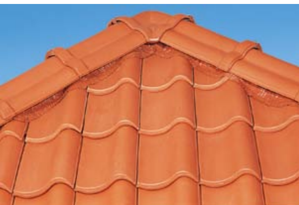
Для конька шатровой крыши существуют т. н. вальмовые заслонки , также изготовленные из обожженной глины.
