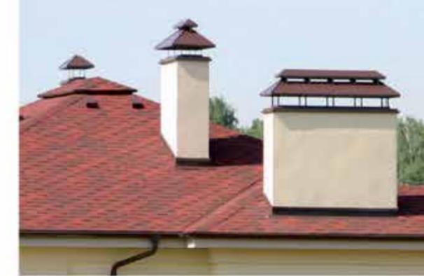
**Колпак ГРАНД** - уникальное изделие, позволяющее решать сложные архитектурные задачи. Хорошо вентилируется, но при этом надежно защищает дымоходный или вентиляционный канал от косого дождя при сильном ветре.
