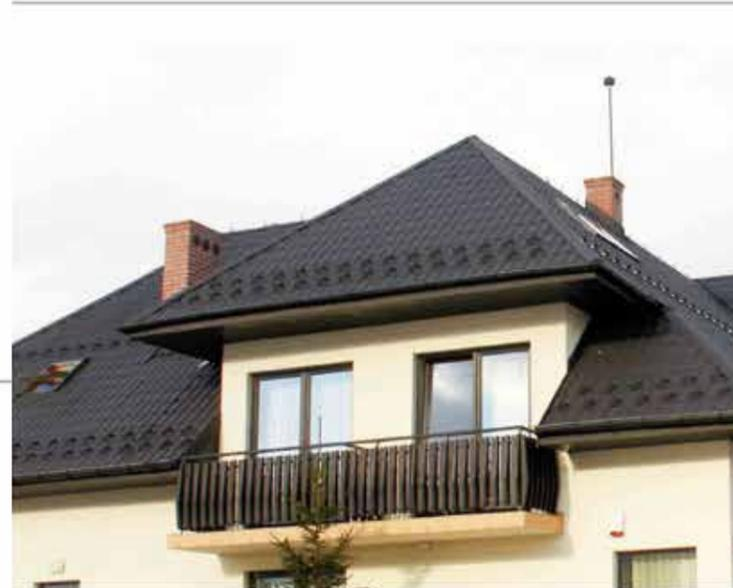
**Снегозадержатель для металлочерепицы** предотвращает лавинообразный сход снега и льда с кровли из металлочерепицы, равномерно распределяет нагрузку снежного покрова на стропильную систему кровельного ската.
