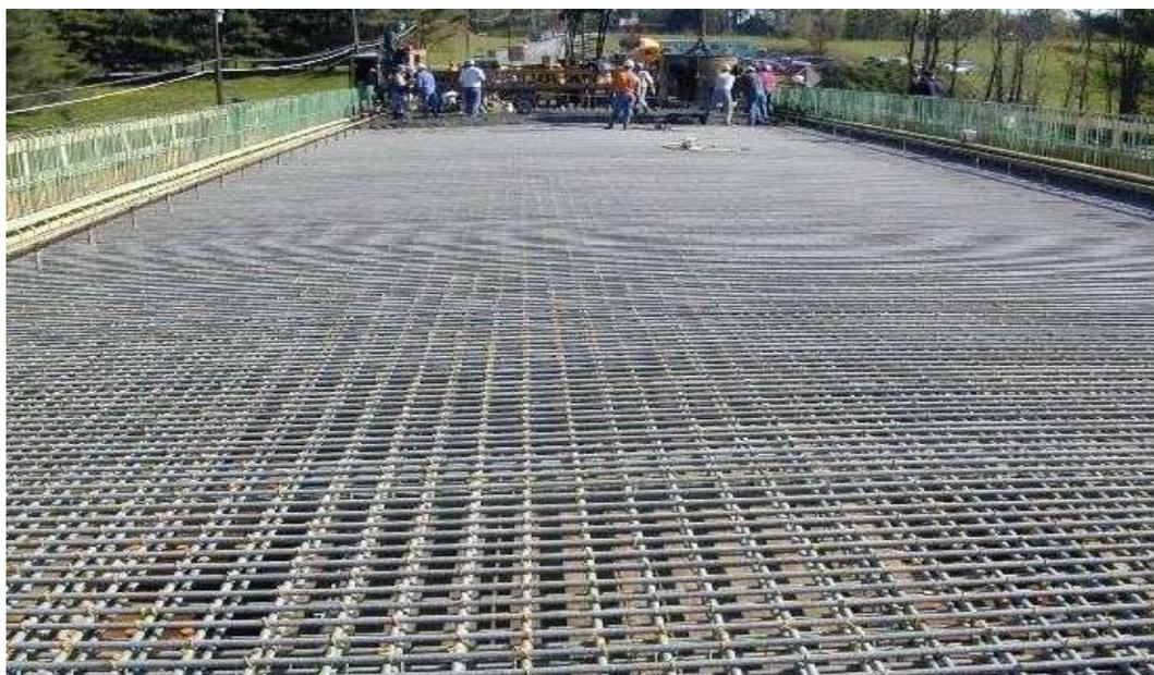
Настилы мостов, армированные композитными стержнями, показали хорошее поведение в очень агрессивной среде (антиобледенители, обледенение/оттаивание, и высокие транспортные нагрузки). При данных условиях дополнительное/прогрессирующее растрескивание не обнаружено.
