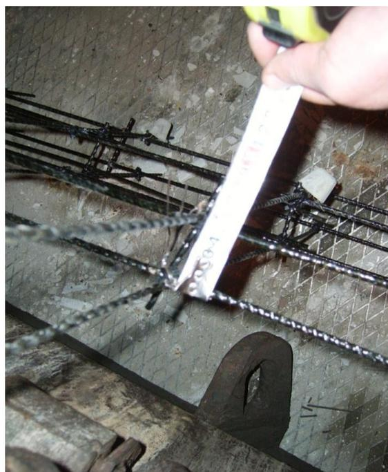
**Рис. 1, 2. Фрагменты арматурных каркасов из базальтопластиковых стержней, уложенных в опалубочную форму дорожной плиты с контролем их геометрических параметров**
