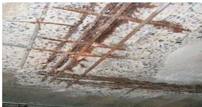
**Разрушение перекрытий парковок с металлической арматурой, подверженной коррозии (Канада)**
