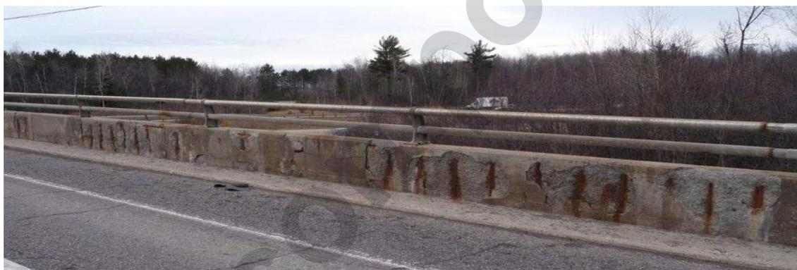
**Разрушение конструкций мостового перехода с металлической арматурой, пораженной коррозией (Канада)**
