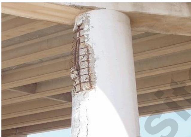
**Пример «отстреливания бетона» вследствие коррозии стальной арматуры в боках моста**
